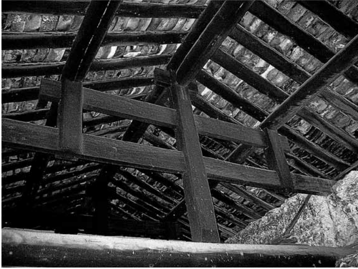
圖 10 福建南靖書洋下版村上節澗濱樓祖廳明間屋頂，本研究計畫攝。
