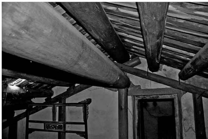
圖 4 臺中后里張天機宅正廳閣樓梁架，李慧貞攝。
